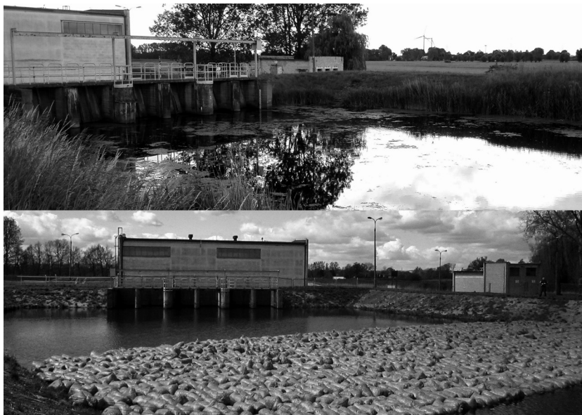
Ryc. 2. Bariera biologiczna ze słomy jęczmiennej w okolicach pompowni zaraz po zainstalowaniu na zbiorniku (dół), oraz po 2 tygodniach od dnia montażu (górze)
