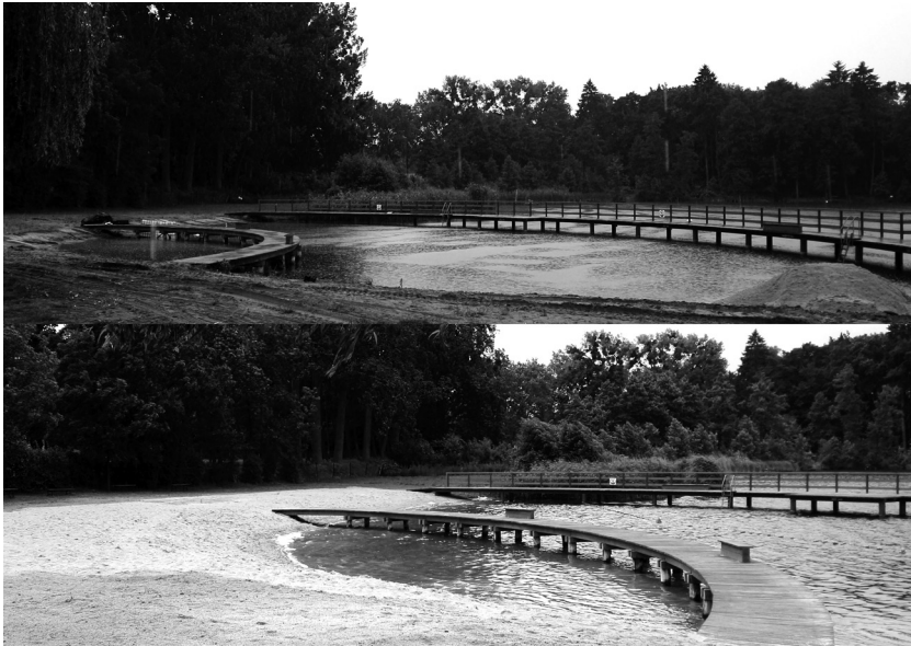
Ryc. 4. Zmiany jakie zaszły na kąpielisku jeziora Siekiera (górze: okres przed przystąpieniem do prac, dół: zakończenie prac)
